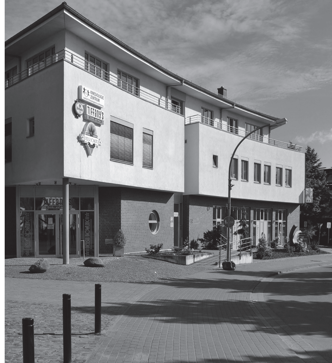
Das IKL-Gebäude mit Blick über die Dächer von Damme
